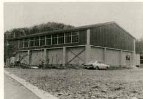
古舞小学校体育館
