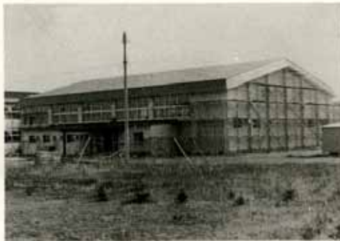
札内南中学校体育館
